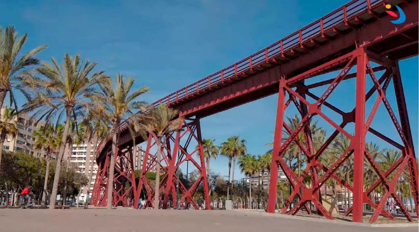
El viaducto metálico ha recuperado su color rojizo original.
