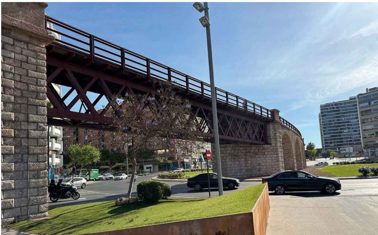
Puente metálico de unión entre dos tramos de obra de fábrica.
